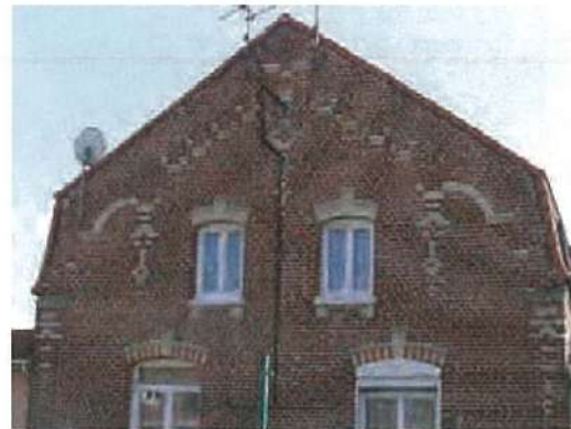
A gauche : Toiture à deux pans. © Mission Bassin Minier
