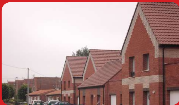
Nouveau bâti, rue d'Entrevaux, à Somain qui s'intègre avec les logements miniers en arrière plan
