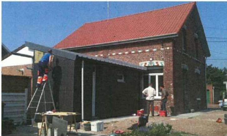
Isolation extérieure d'une extension.
