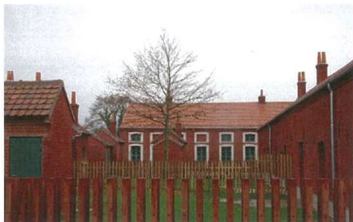
Maisons traitées avec un badigeon à la chaux.
