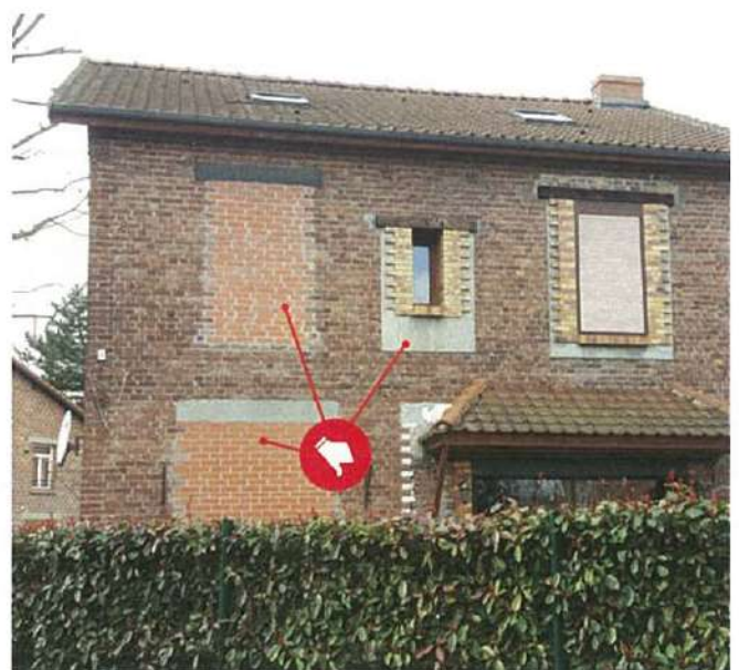
Modifications de baies.
