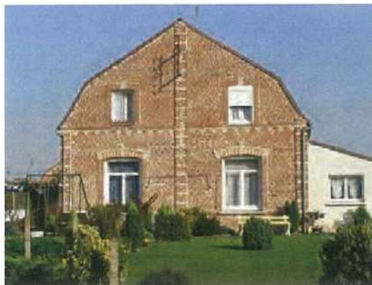
Détail d'un pignon d'une habitation regroupant 4 logements. © Mission Bassin Minier
