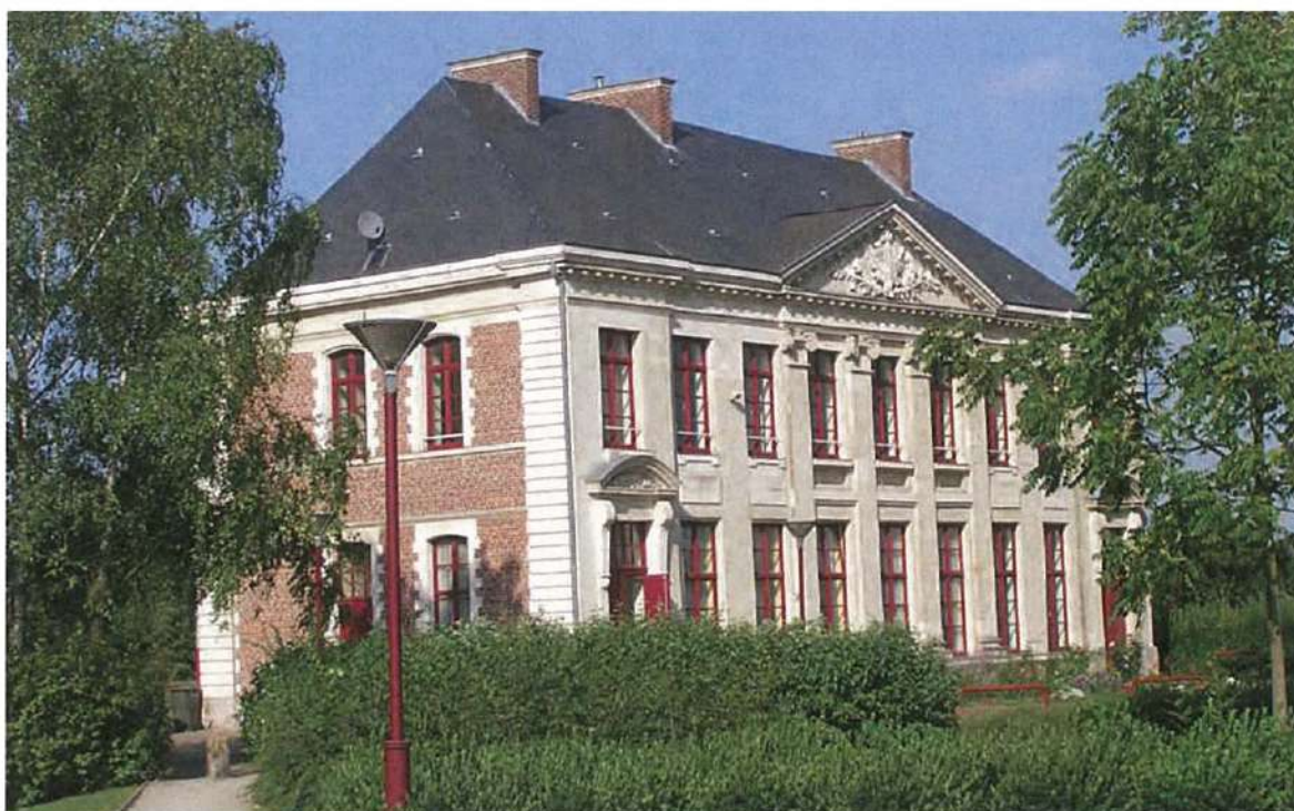
Vue d'ensemble du prieuré et détails des façades Sud et Ouest.
