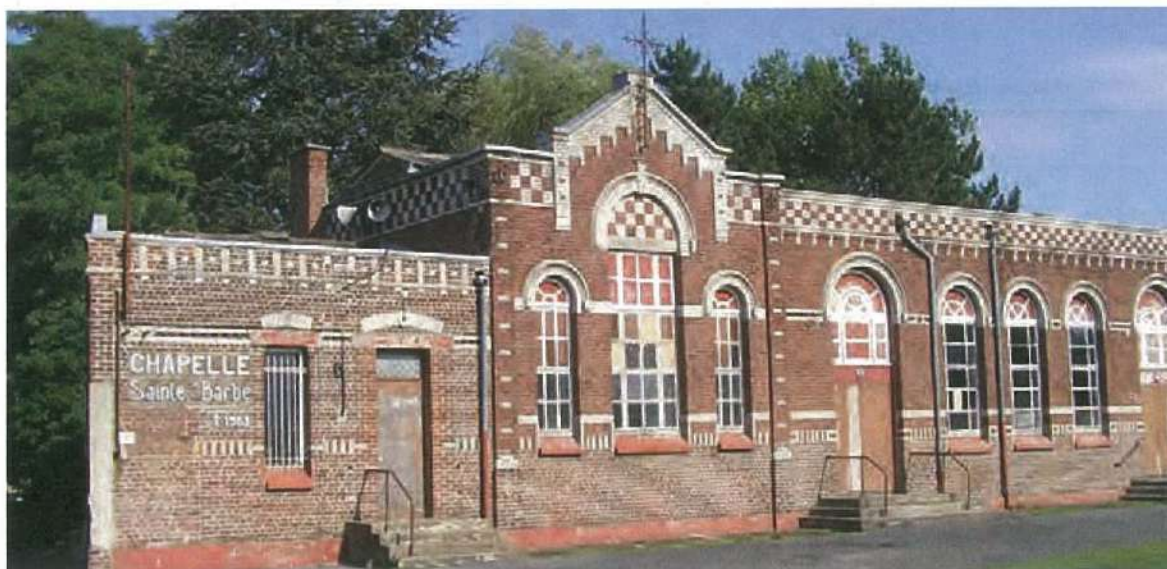
Détails architecturaux de la façade. © Mission Bassin Minier
