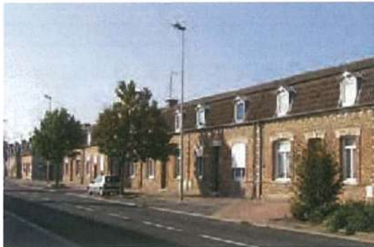
Ci-contre : Barreau regroupant 6 logements. © Mission Bassin Minier
